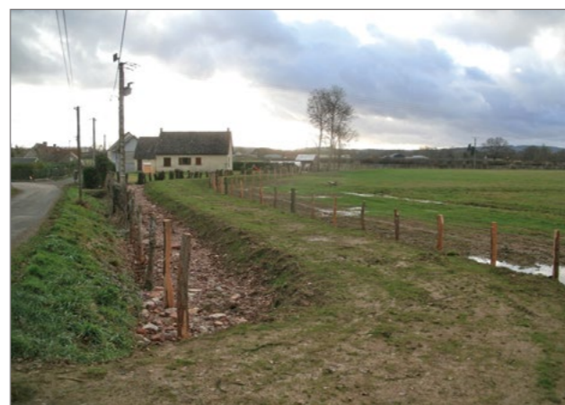
Aménagement réalisé en octobre 2018 au même endroit afin de contenir les eaux de débordement de la Thouane dans l'herbage situé en amont du hameau.
